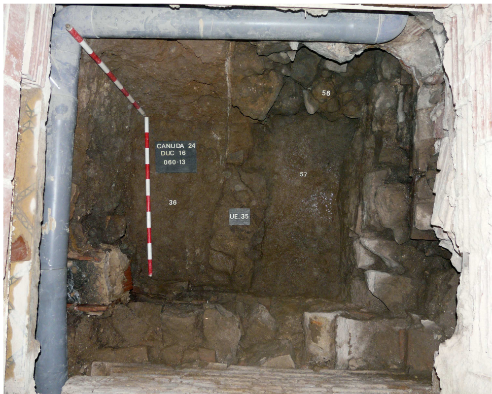
C/ DE LA CANUDA, 24 – C/ DEL DUC, 16 (Barcelona). -Dues vistes del fossat per a l'ascensor. A dalt podem veure alguns dels carreus i de les pedres del mur UE 56 que són reaprofitats per la UE 35. A baix ja s'han desmuntat parcialment ambdós murs.
